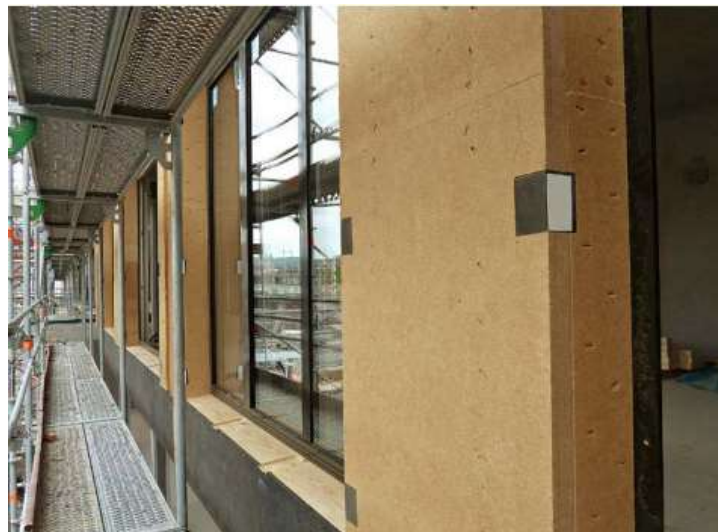
Fotos Pavatex, Schweiz Energetisch optimierter Gewerbebau mit Holzweichfaser
