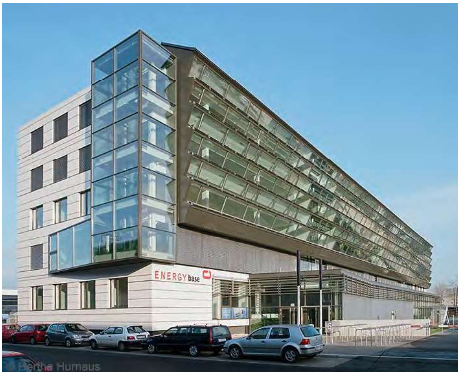
ENERGYbase Solarfassade mit PV by AIT (Energy Planning) and POS Architects, Ursula Schneider
