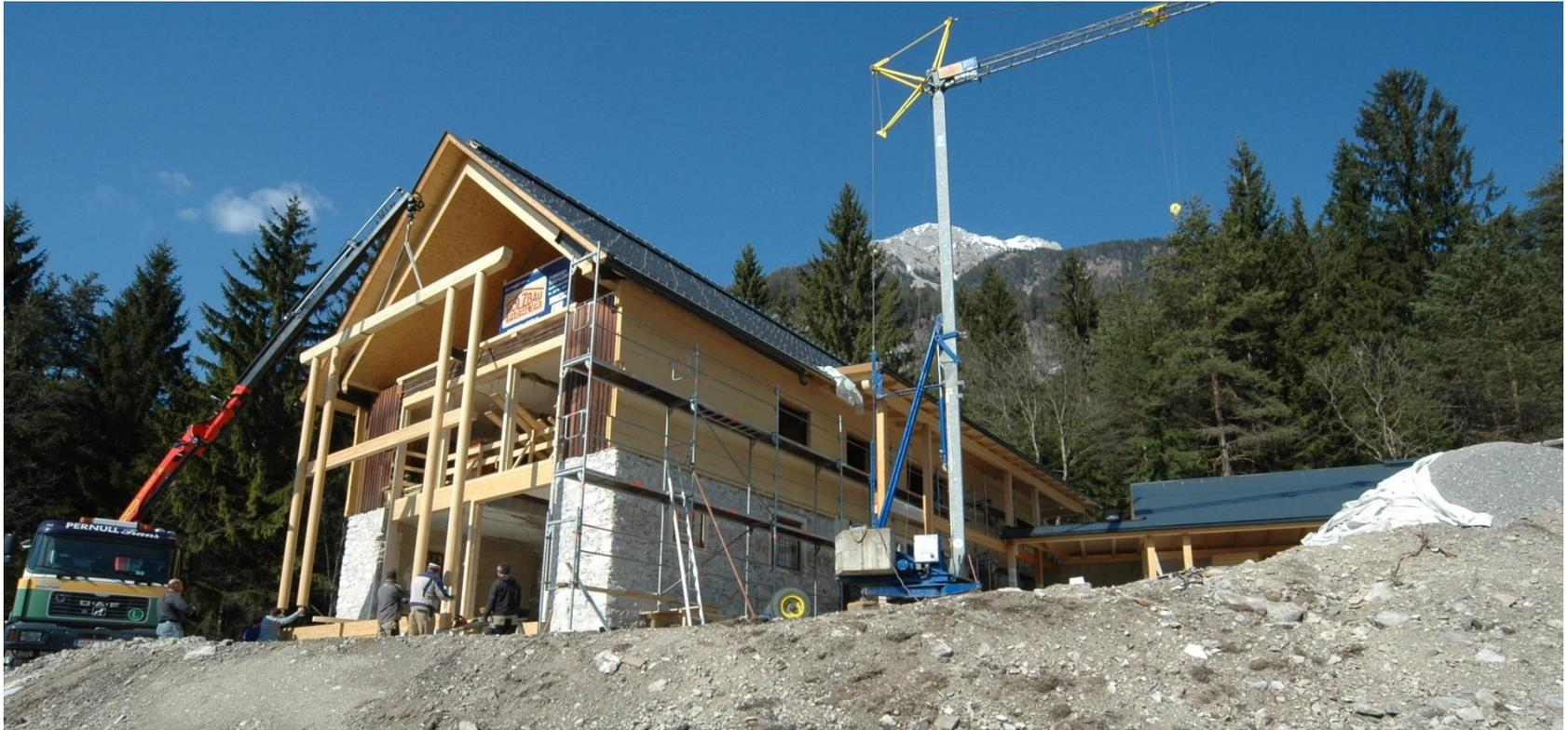
An der ostseitigen Holzriegelwand wurden bereits die außenliegenden Holzweichfaserplatten montiert.
