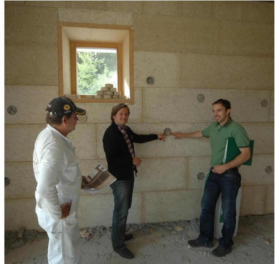
Einbau von Messsonden zur Überprüfung der Feuchtigkeit
